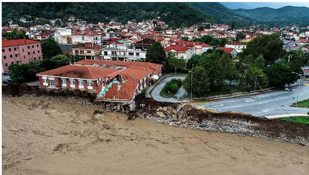
Εικόνα 24. Πλημμύρες και κατολισθήσεις στο Μουζάκι Καρδίτσας ( photoEurokinissi ).
